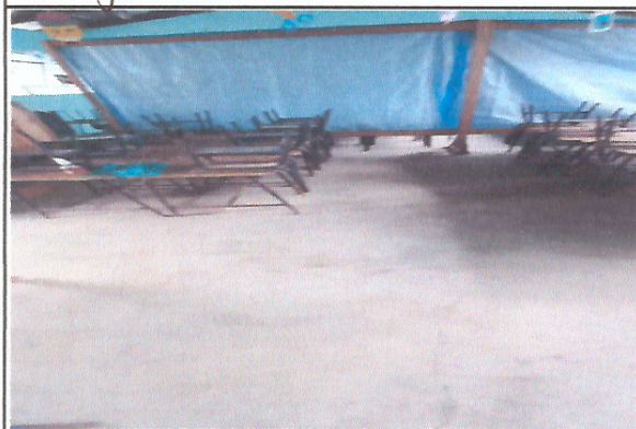
Foto 3: Mejoramiento de piso a
