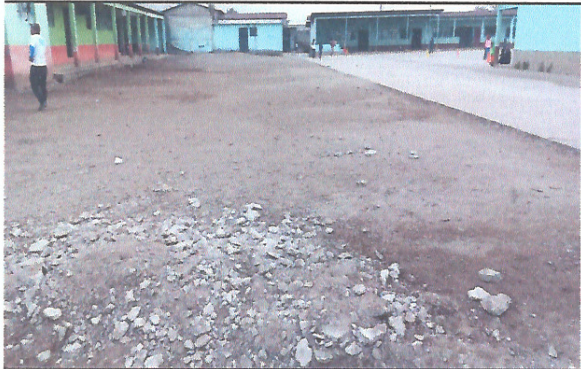
Foto 1: Mejoramiento de losa de
